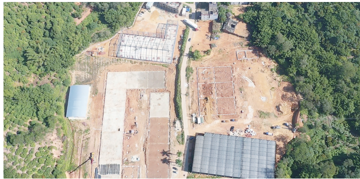
建设中的高州市香蕉产业园。
