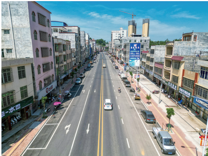
文楼镇府前路改造后。
