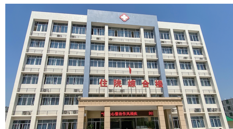
标准化建设的霞洞镇卫生院住院综合楼。
