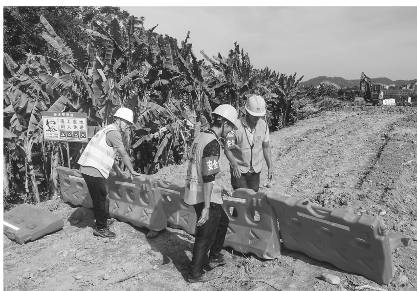
农民工安全督察队认真排查纠正安全隐患。 通讯员 伍朝礼 摄
