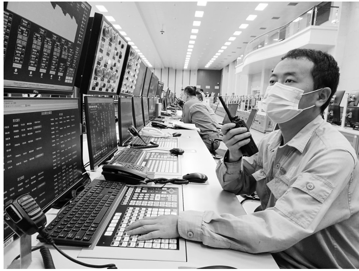
茂名石化广大员工积极投身驻厂工作,守护装置安全环保运行,确保生产平稳。 通讯员 柯裕清 摄
