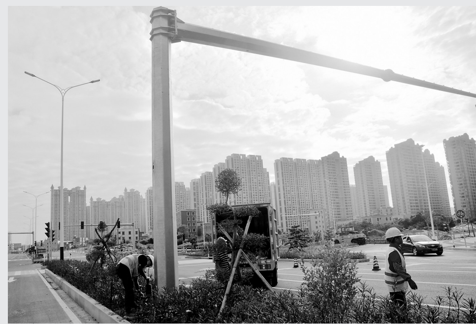
昨日,记者在市区官山七路与东粤路交汇处看到,施工工人正在加紧安装电子监控系统。据了解,官山七路预计春节前完成整个项目建设。 茂名日报社全媒体记者 陈国汉 摄
