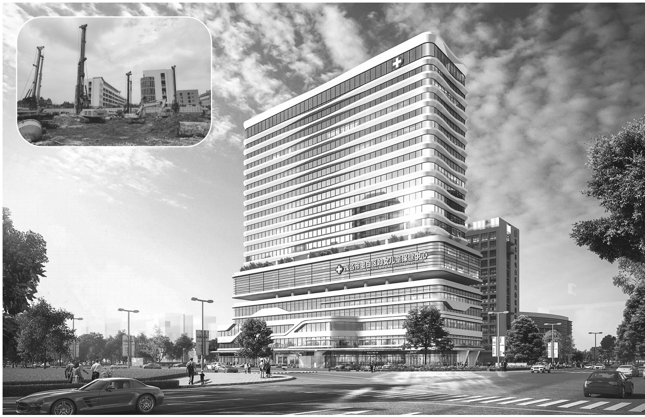
大图为效果图,小图为施工现场。
