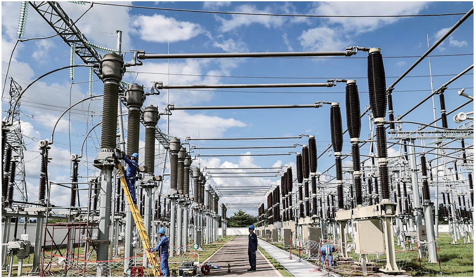
茂名供电局变电工作人员顶着烈日、冒着高温对220千伏铁变变电站的变电设备进行检修维护。
