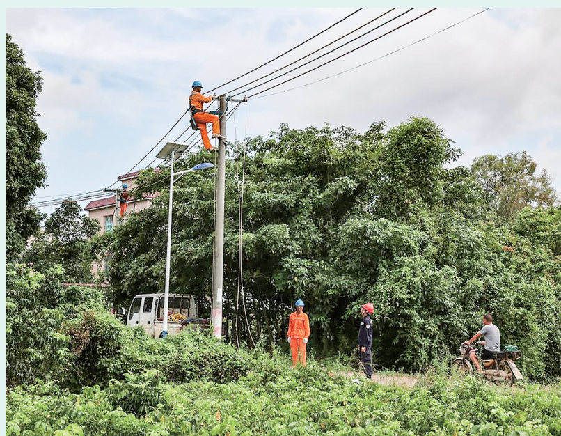
茂名化州供电局施工人员顶着烈日,在杆上作业3个多小时,对配电网线路进行更换。
