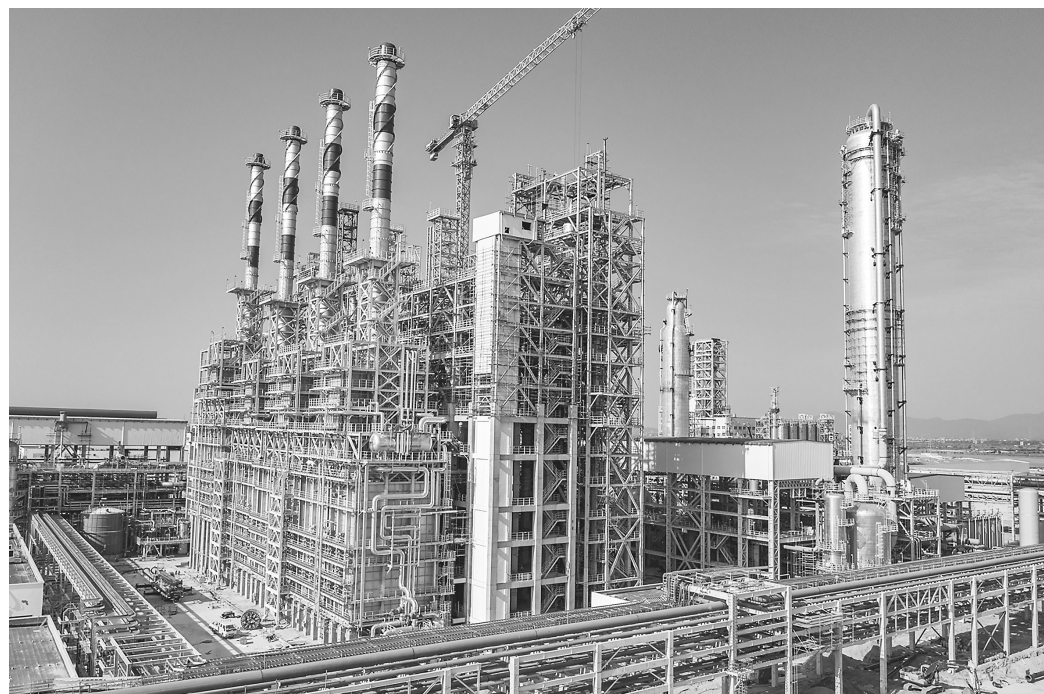
一座现代化绿色化工和氢能产业园正在崛起。如图60万吨年丙烷脱氢装置。 本报记者 丘立贺 摄
