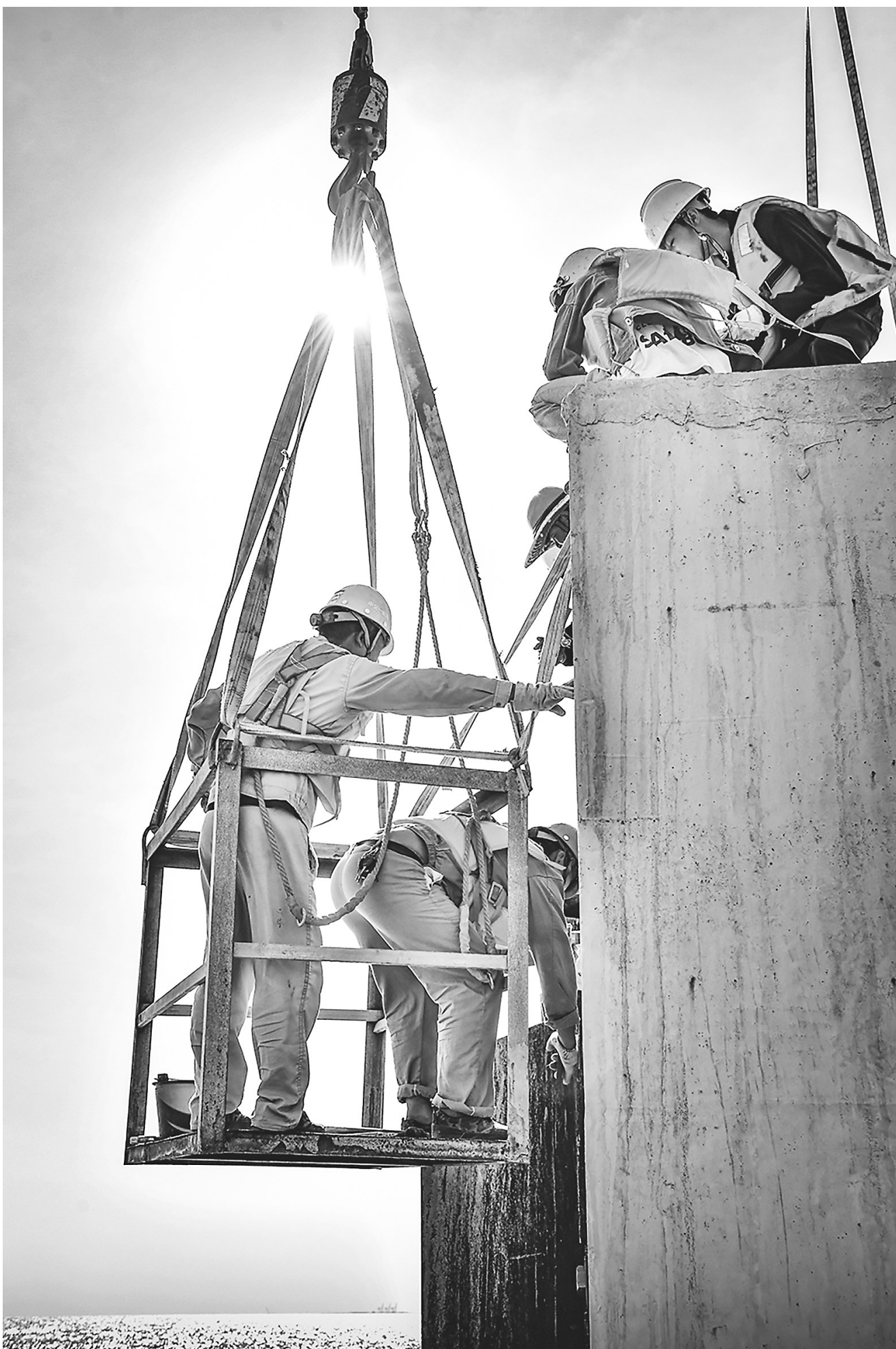
施工人员正在高空冒着寒风施工。通讯员 刘武基 摄
