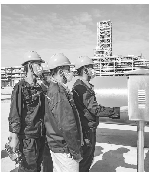
施工技术人员在仔细检查各部件的调试状况。 本报记者 丘立贺 摄
