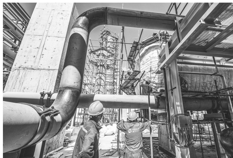
东华能源(茂名)烷烃资源利用项目一期的工地现场,机械轰鸣,大地上奏响活力绽放的序曲。 通讯员 刘武基 摄
