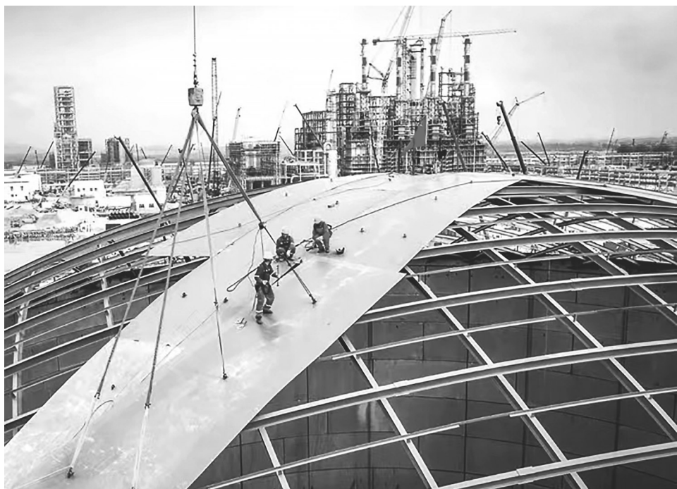
施工人员进行吊装作业。 通讯员 刘武基 摄
