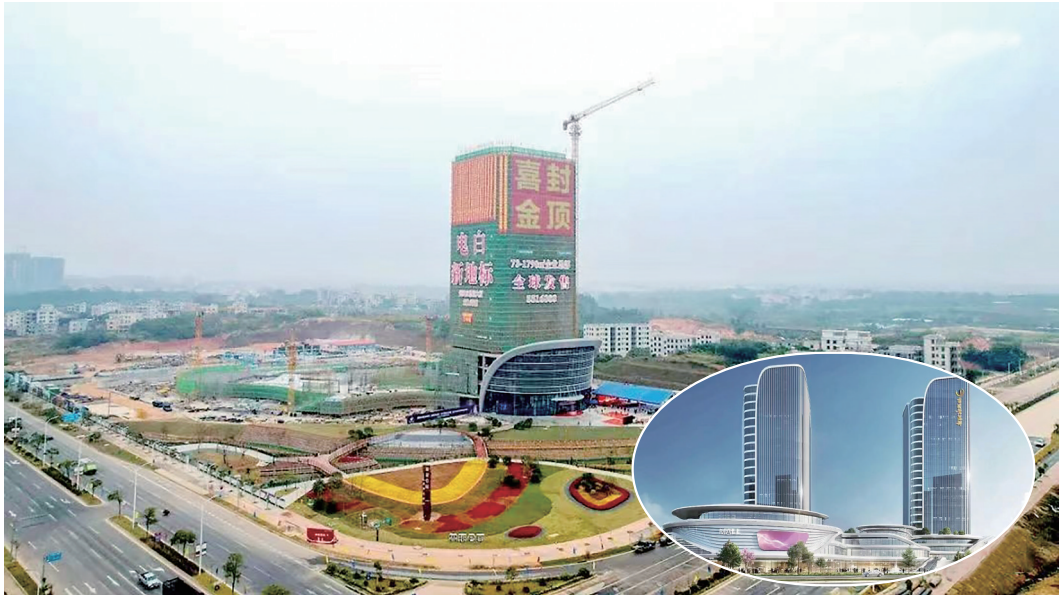
大图广东省重点建设项目——电白区建筑业总部基地大厦主楼日前封顶。
