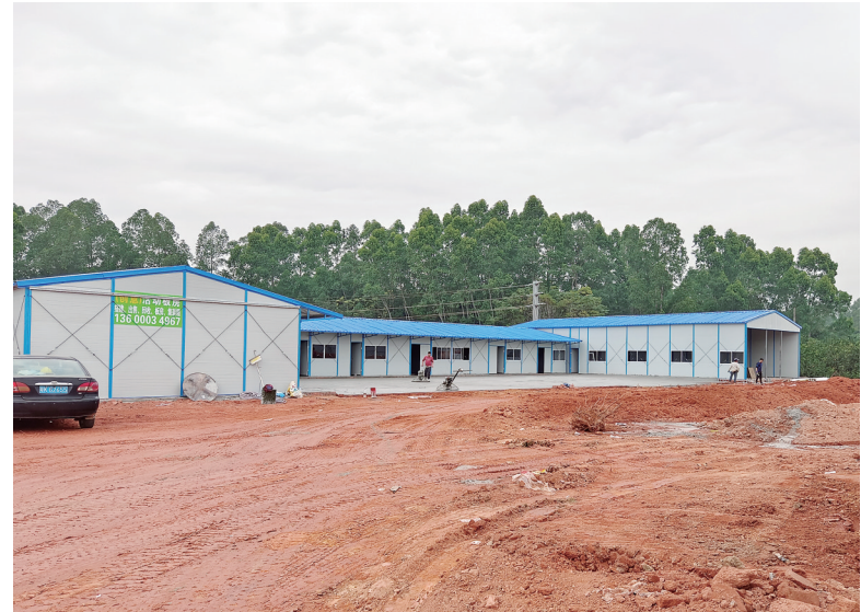
施工现场一角。
