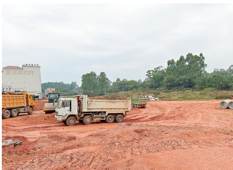
工程项目施工现场。
