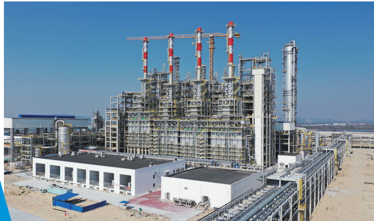
滨海新区:东华能源茂名烷烃资源综合利用项目一期60万吨丙烷脱氢装置。本报记者 丘立贺 摄
