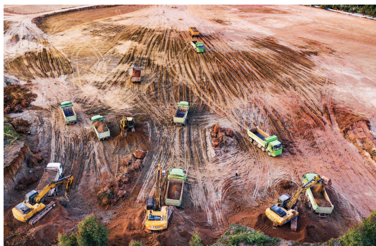
茂南区天然气热电联产保障电源项目施工现场。本报记者 丘立贺摄
