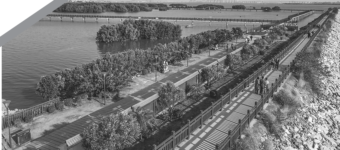
电白区水东湾生态修复工程。本报记者 丘立贺 摄
