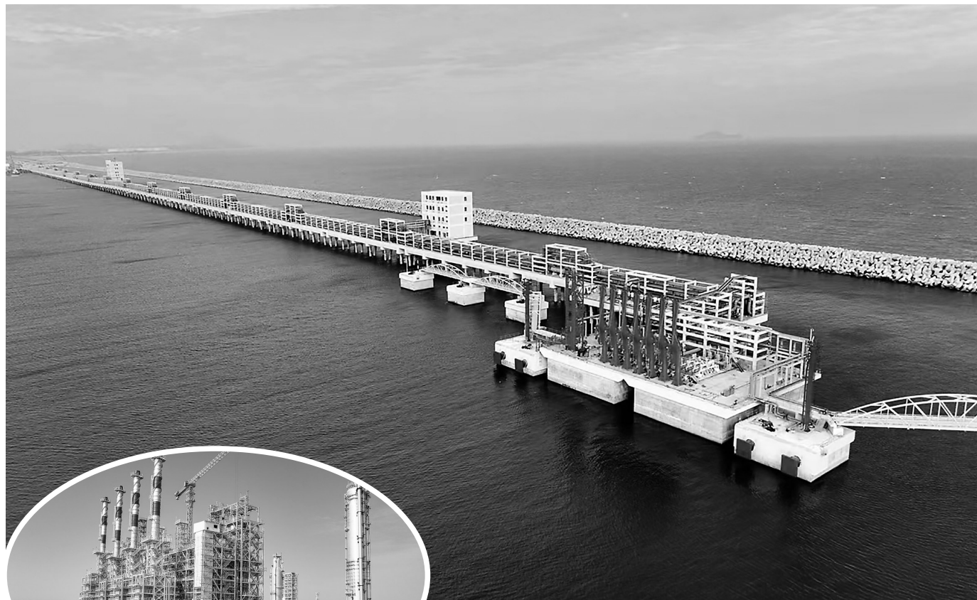
▲茂名港集团建设的博贺新港区10万吨级成品油码头。
