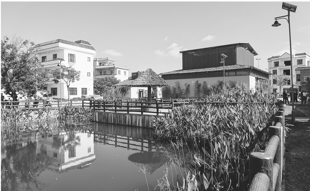
高州分界杏花村生活污水治理池。
