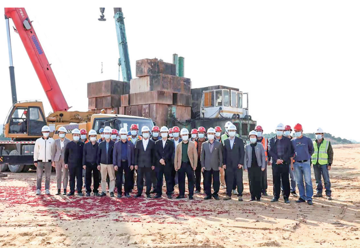
2022年12月11日,电白区人民医院分院建设项目举行静压试桩施工仪式
