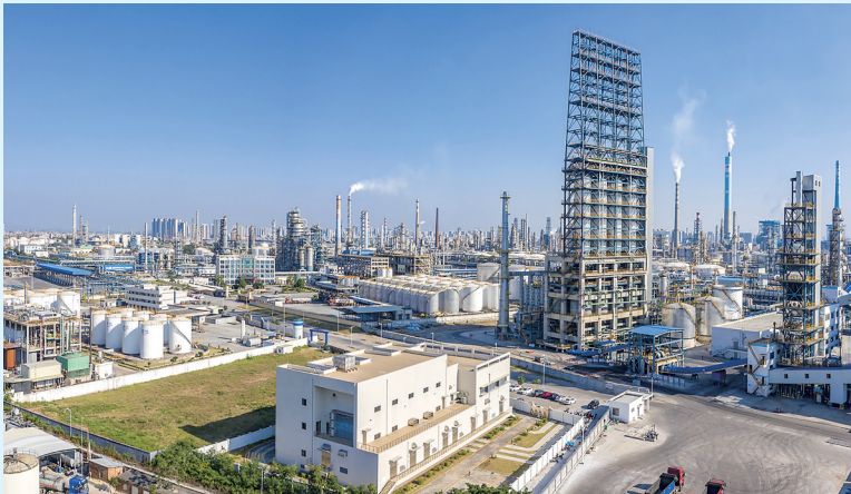
茂南区加快推进石油化工项目建设。
