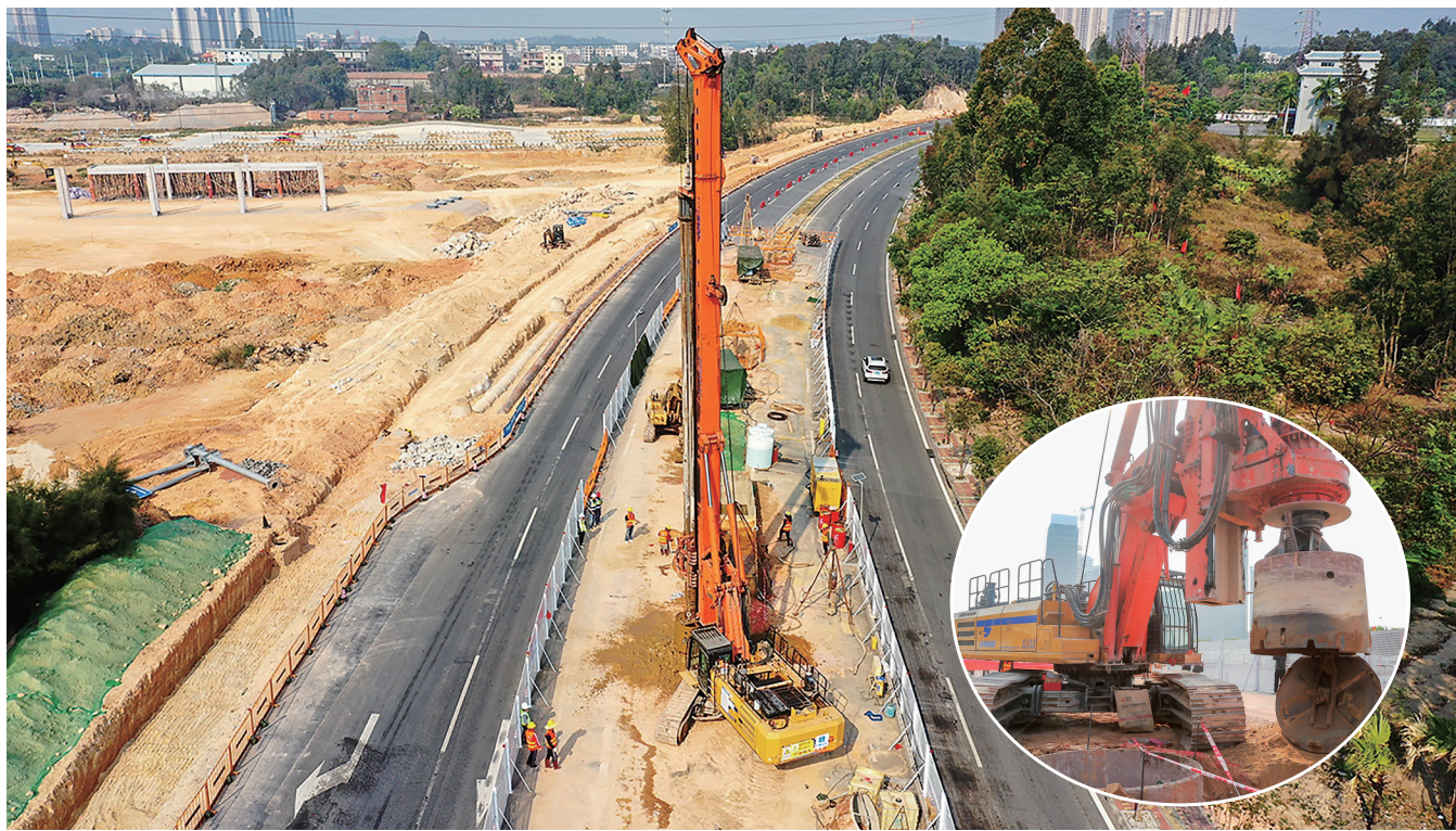
海洋大道立交项目首桩开钻。茂名日报社全媒体记者 岑稳 通讯员 杨其松 摄
