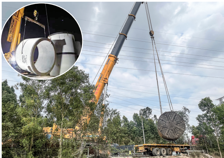
顶管设备吊装转运作业。通讯员 钟学有 摄
