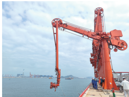
油品码头输油臂调试成功。
