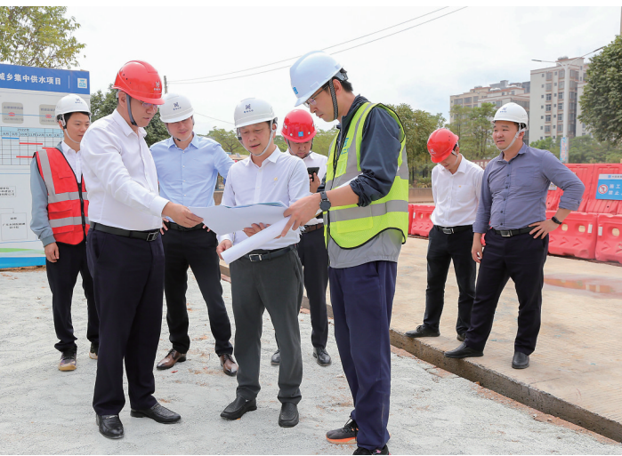
魏用杰(前右一)与同事一起在现场会商施工作业。
