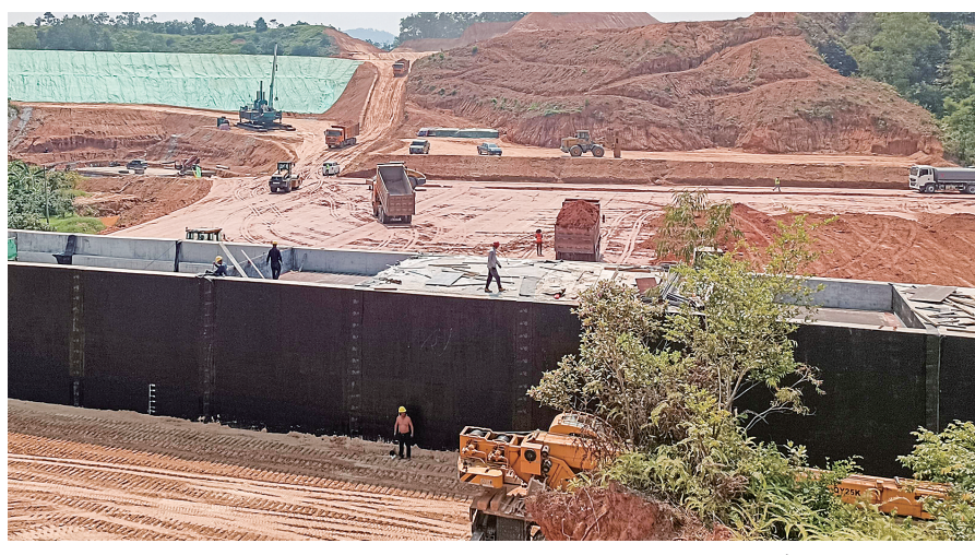
北界东互通建设现场。
