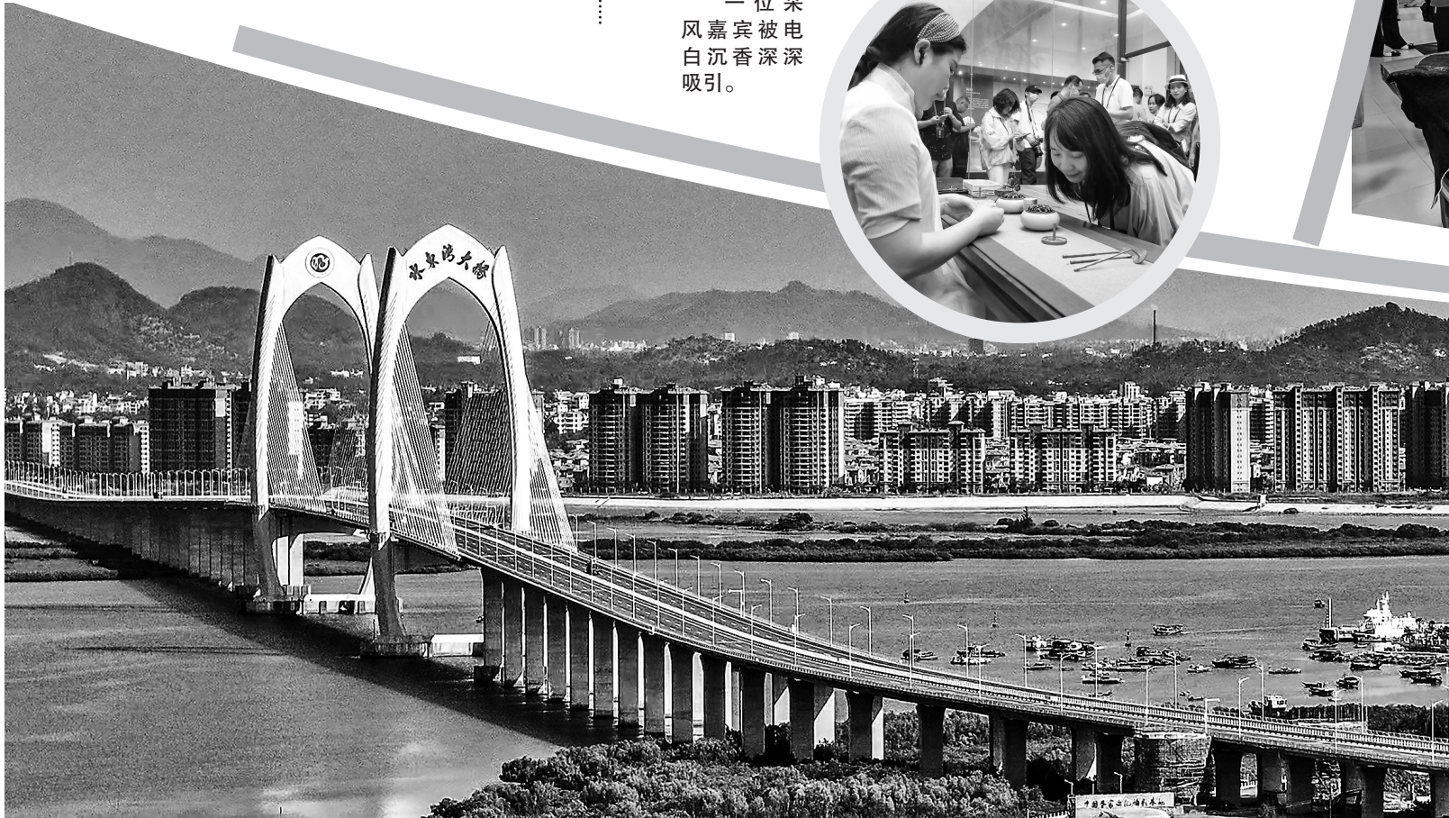
雄伟的水东湾大桥。
