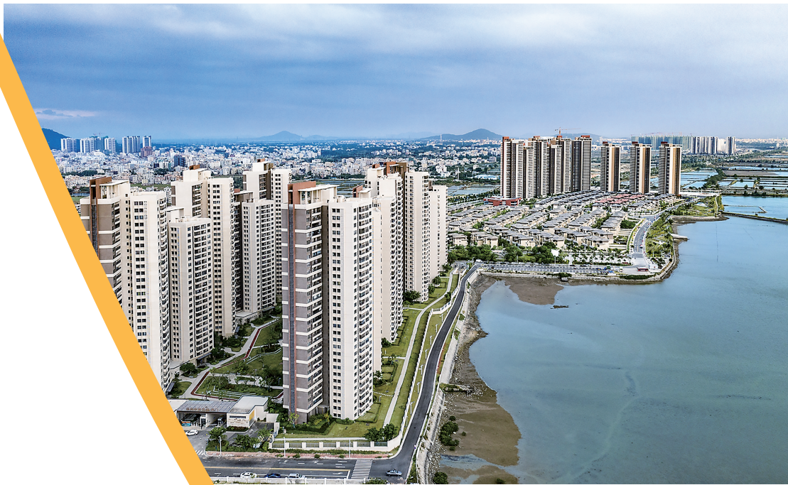
滨海新区港湾新城拔地而起的楼群。
