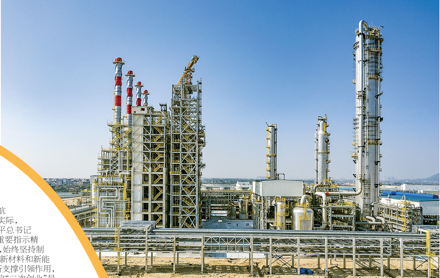
东华能源(茂名)烷烃资源综合利用项目一期建成试车。
