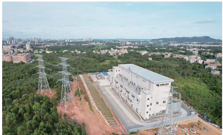
图为茂名220千伏晏镜变电站。通讯员 廖香兰 摄
