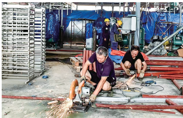
▲广东泽丰园农产品有限公司加紧组建全新荔枝商品化处理生产线,借助RPEC全面生效的红利扩大荔枝出口业务。图为施工人员正使用电动工具切割钢材。叶茂 摄
