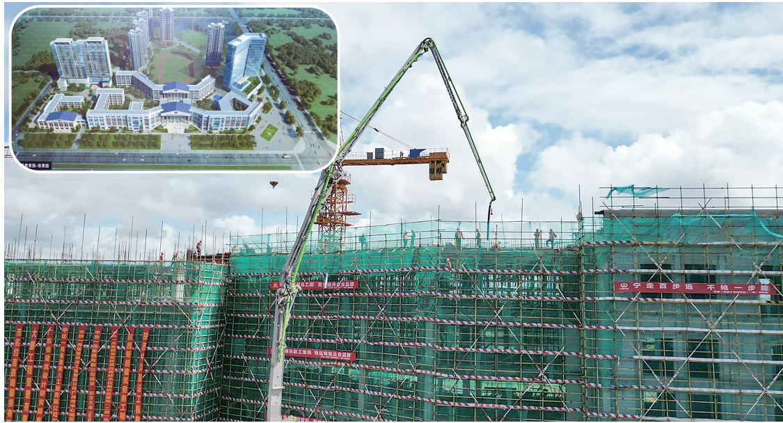
大图:爱丁堡教育园一期项目主体封顶。 小图:教育园项目效果图。本报记者 黄信涛 摄
