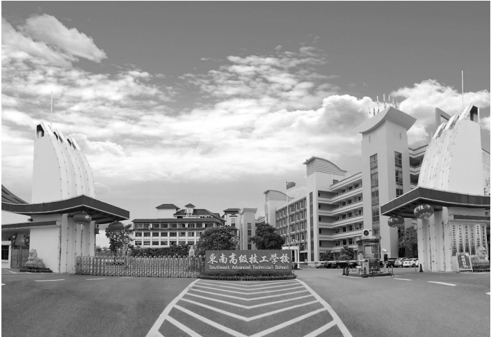
东南高级技工学校。
