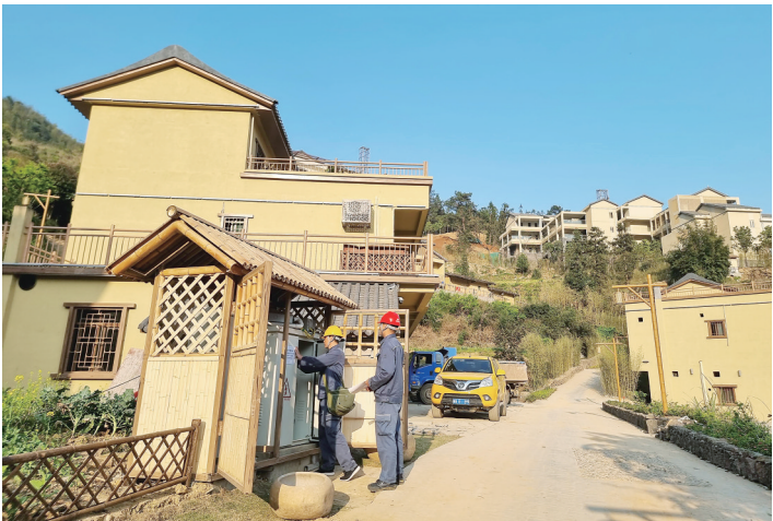
平塘供电所工作人员对马安竹海电力设备开展验收检查。 通讯员 黄华国 摄
