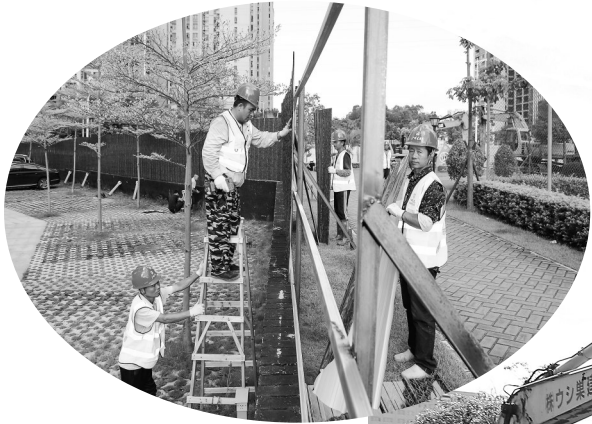
工作人员在安装围挡。
