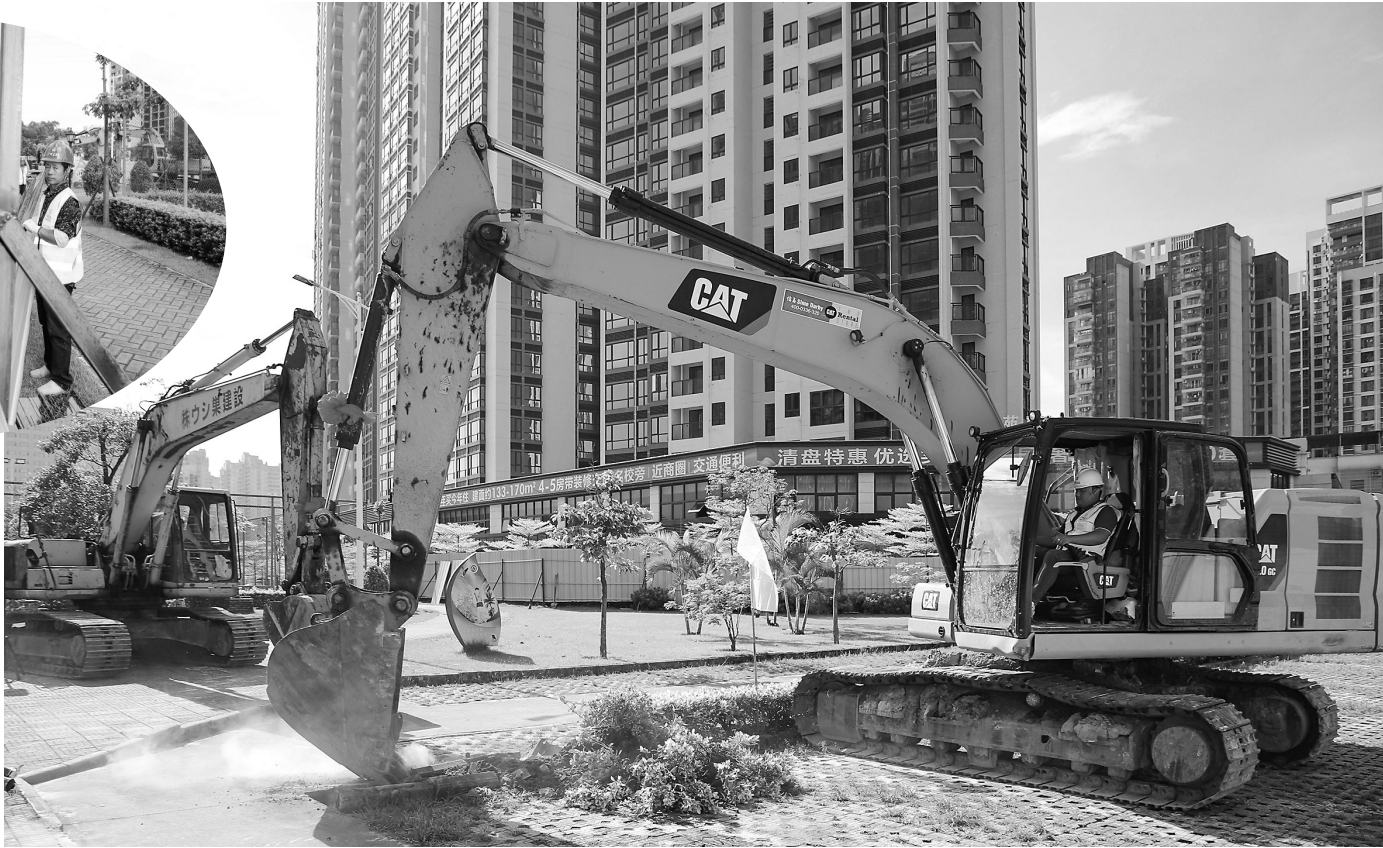
开工仪式现场钩机启动挖土。
