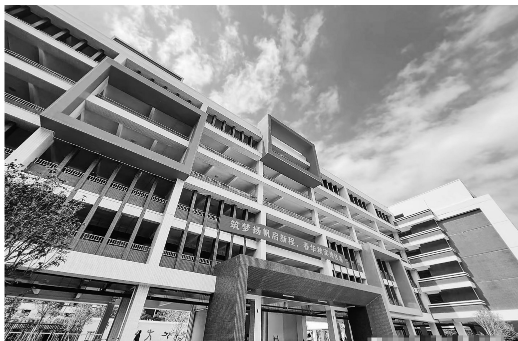
▲图为市西粤路小学教学楼。 茂名日报社全媒体记者 吴云杰 摄
