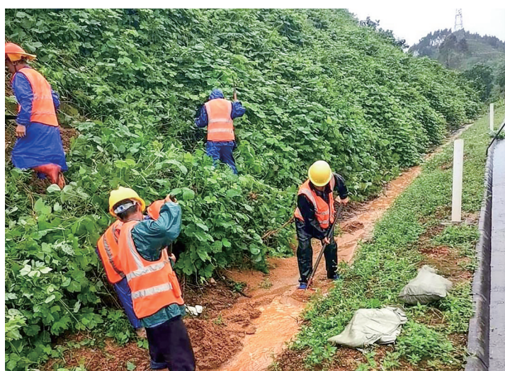
养护人员及时疏通高速公路边坡排水沟。
