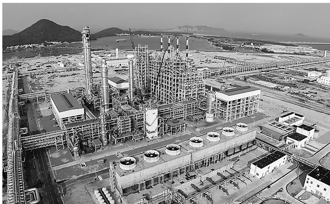
滨海新区各绿色化工企业建设如火如荼。茂名日报社全媒体记者 甘杨松 摄
