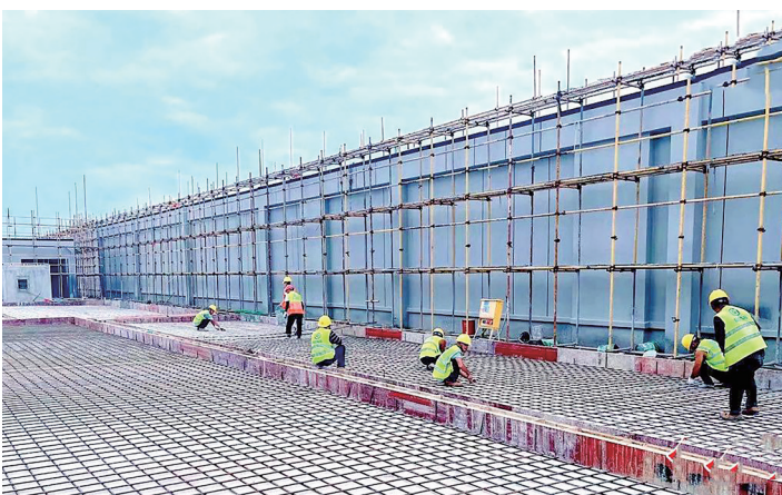
欣捷安(电白)一期项目建设现场。
