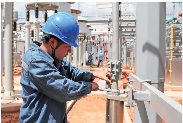
▲在500千伏电白变电站,工作人员在调试设备。
