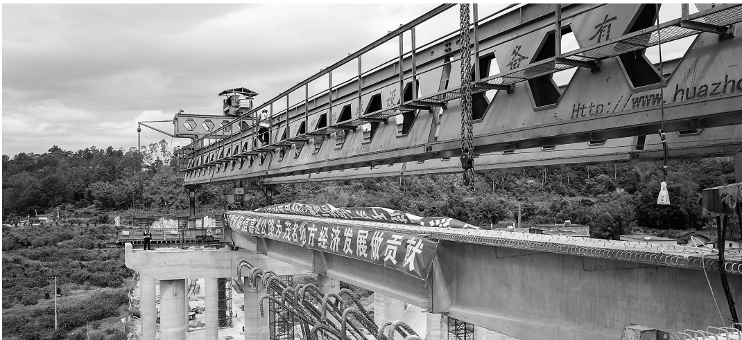
首片40米T梁铺架现场。通讯员 韦商标 摄
