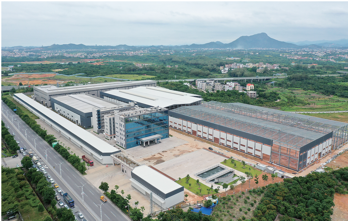
中力恒金属项目 高融媒 摄
