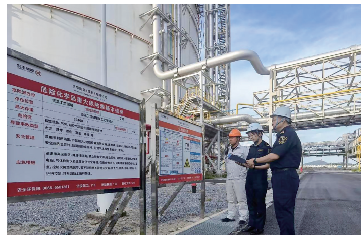
海关关员对东华能源罐区进行日常监管。
