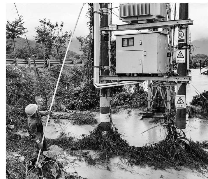
电白供电局抢险人员正在抢修户外供电设备。
