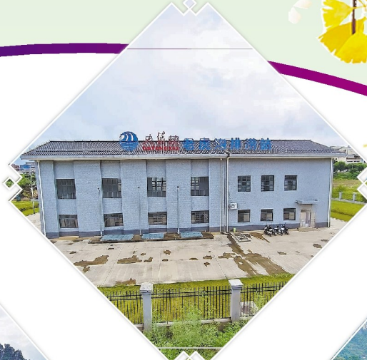
▲大藤峡老虎沟排涝站。
