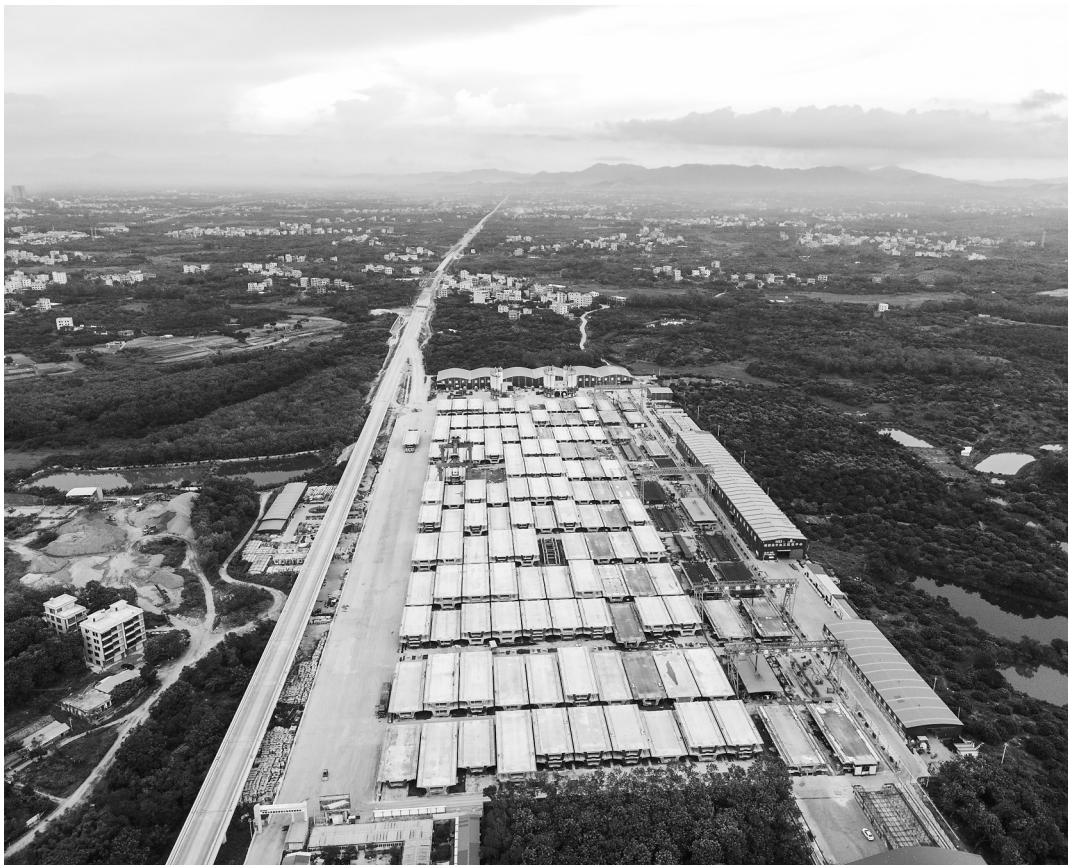
施工现场井然有序。通讯员 武聚盟 摄
