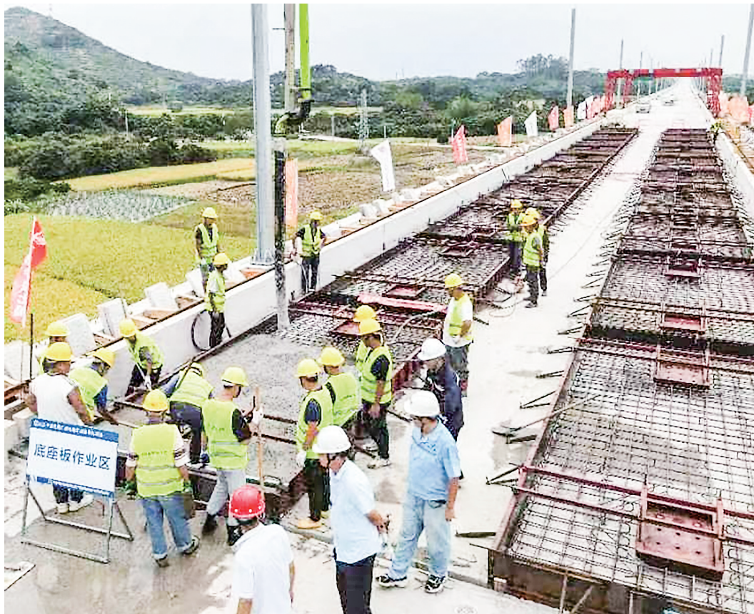
无砟轨道工程首件开工现场。通讯员 武聚盟 摄
