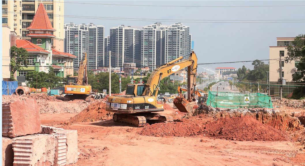
东粤路南段正加紧施工。茂名日报社全媒体记者 岑稳 摄
