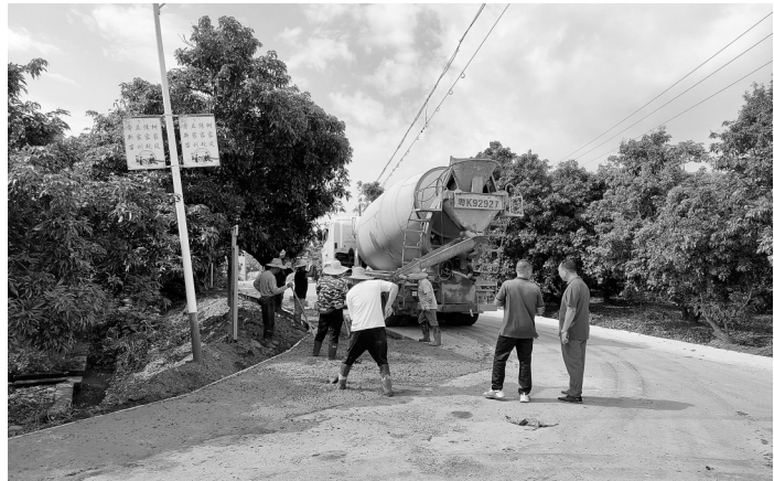
建设中的道路。通讯员 邹云易 摄
