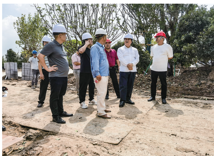
市住建局领导深入房地产项目现场,通过走访、调研、召开座谈会等方式,对项目急需解决的问题,实行点对点服务,主动为房地产企业排忧解难。
