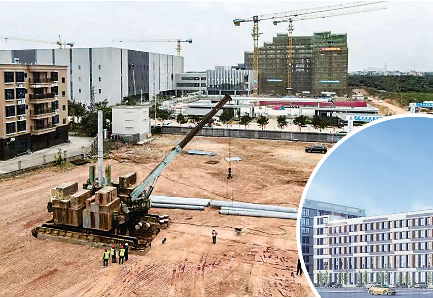
▲茂名市百强微电子有限公司项目正式开工建设。 通讯员 何伟 摄
