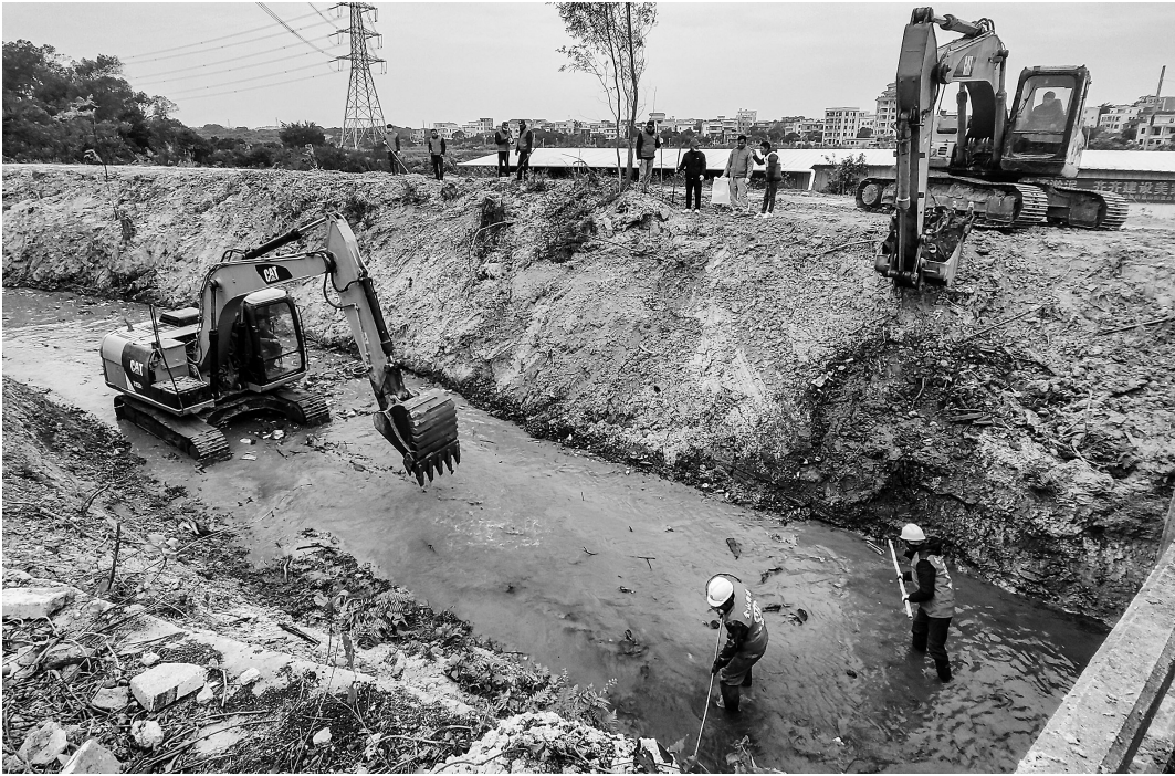
河道清淤现场。通讯员 谭颖模 摄
