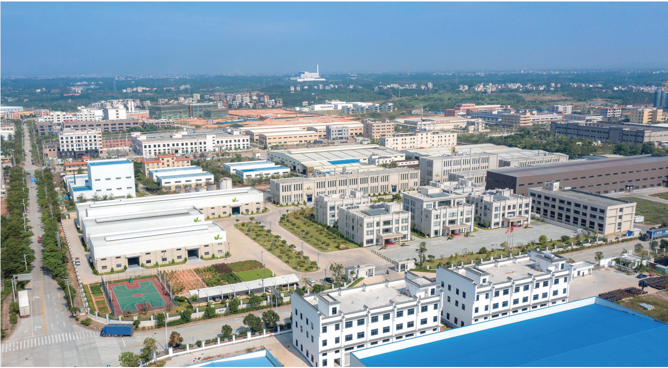
瑞生科技园一座座崭新的厂房拔地而起，一个个新企业相继建成投产。通讯员 何伟 摄
