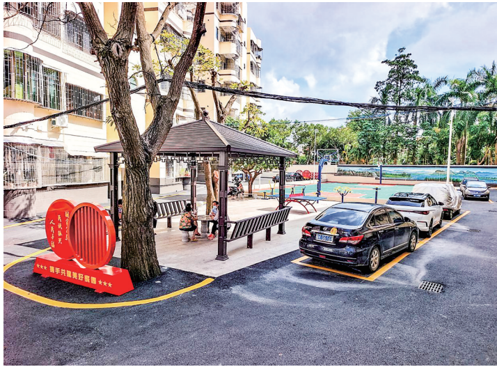
改造后的茂名市电白区东彩小区。
